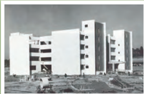
建設中 真っ白で斬新なデザインの旧本館
