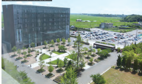
本館・ドルフィン広場完成
