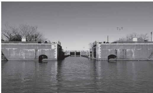
横利根閘門（利根川の門扉）2022年2月25日筆者撮影 ※閘門とは「水位の異なる河川や運河、水路の間で船が航行できるように水位を調整する施設」（『横利根閘門』より）。
