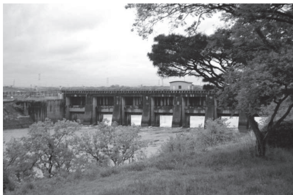
写真1 関宿水閘門全景 撮影：林 健一 2013.4.21
