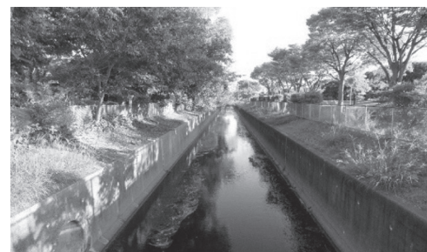
護岸工により底打ちの三面コンクリート水路 千葉県柏市:地金堀都市下水路(※7) 撮影:著者 2024年10月20日
