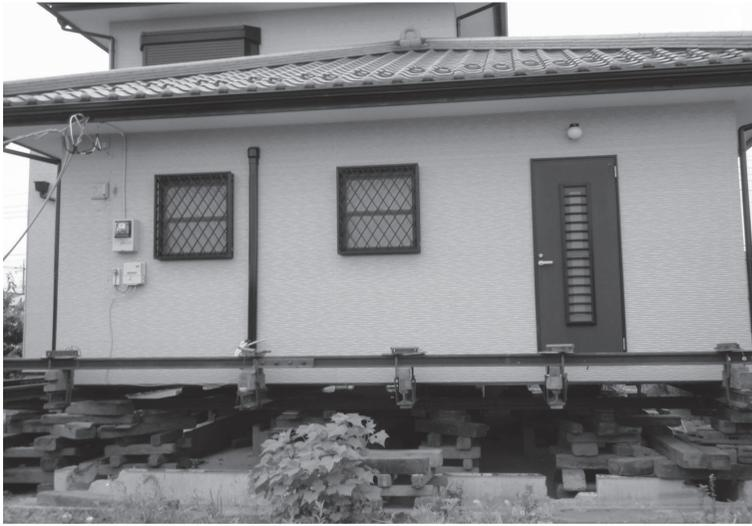
大規模な基礎の修繕工事(曳家による基礎改修工事)
