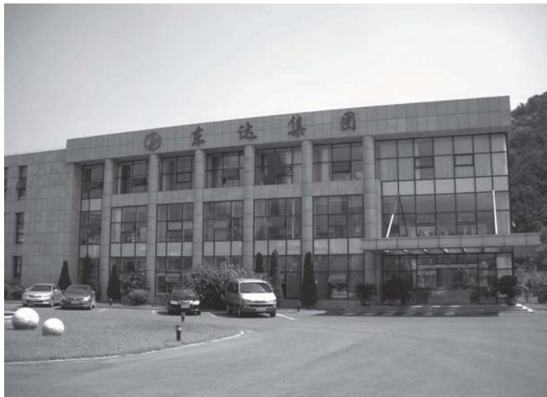
写真1 「馬欄河污水处理場二期」の管理棟 撮影：佐藤 寛 2012年8月29日
