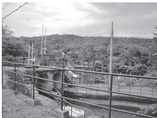
遠刈田発電所への取水口 撮影：筆者 2015 年 6 月 20 日
