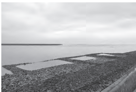
写真 3-2-2 「鹿島肥前干潟」（未増築排水樋管付近）
