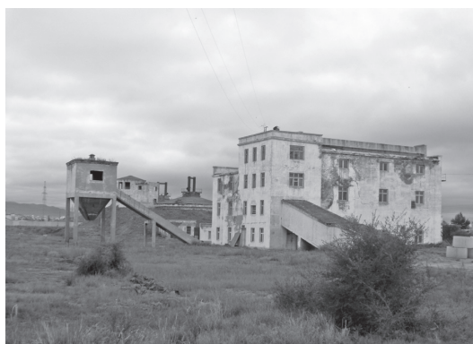
写真1 老朽化が目立つ中央下水処理場
