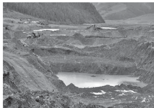
写真1 オルホン川 沈殿池
