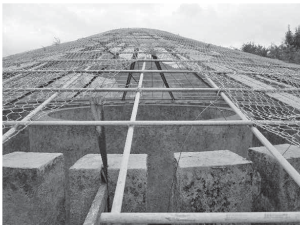
3 円筒分水槽は金網で覆われている
