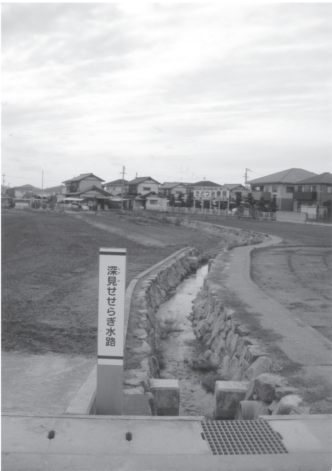
写真 1 深見せせらぎ水路
