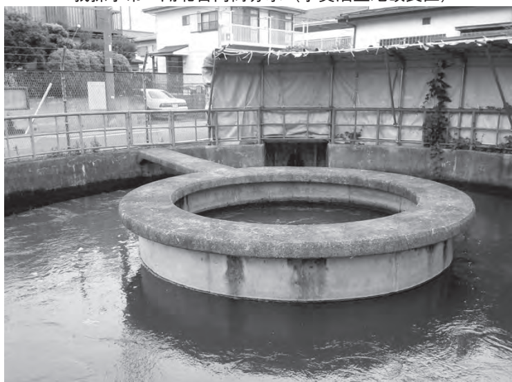
我孫子市 湖北台円筒分水（手賀沼土地改良区）
